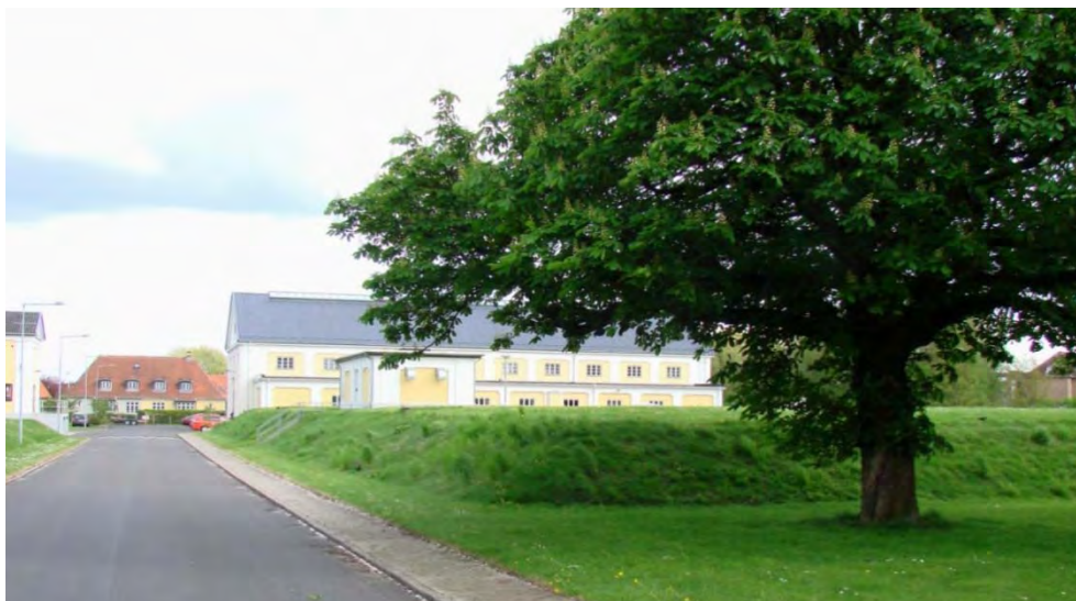
Figur 9-28 Værket ved Islevbro ligger i tæt bebygget område ved Husum i Storkøbenhavn.
