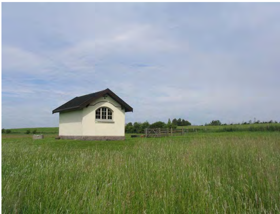
Figur 9-13 Den lille vandværksbygning på Toroslunde Kildeplads ved Kirkeengen.
