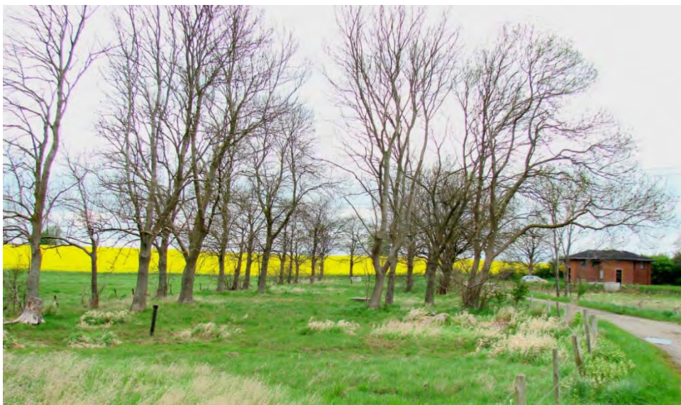
Figur 9-18 Kildeplads ved Værebros Å. Imellem træerne ses flere brønde og til højre i billedet en vandværksbygning.
