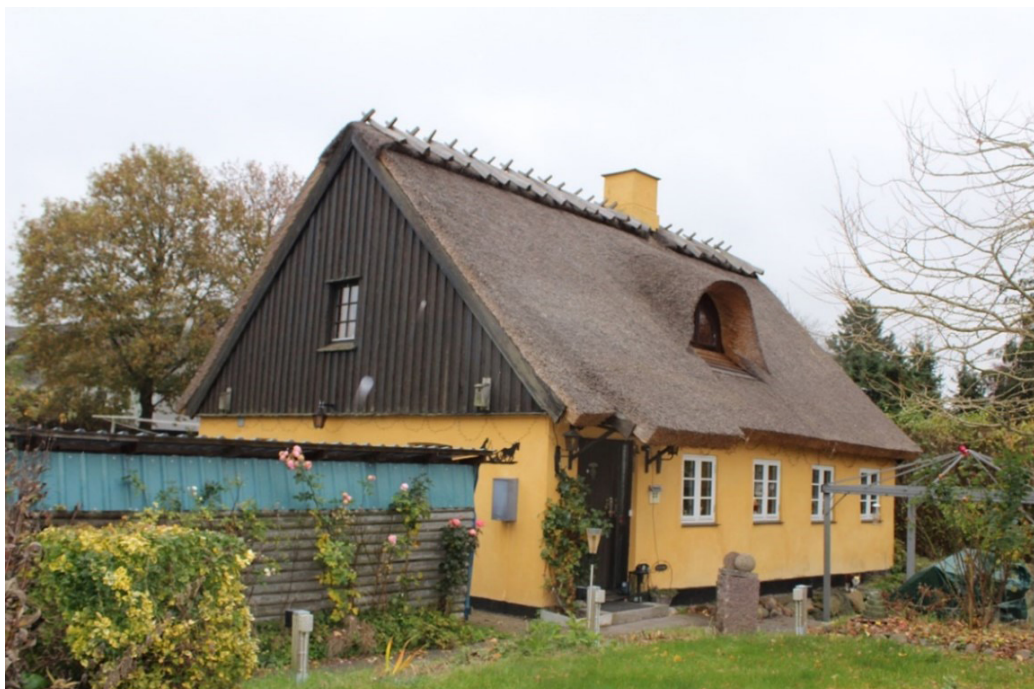
Foto: Sydvendt facade set fra Søndre Byvej
