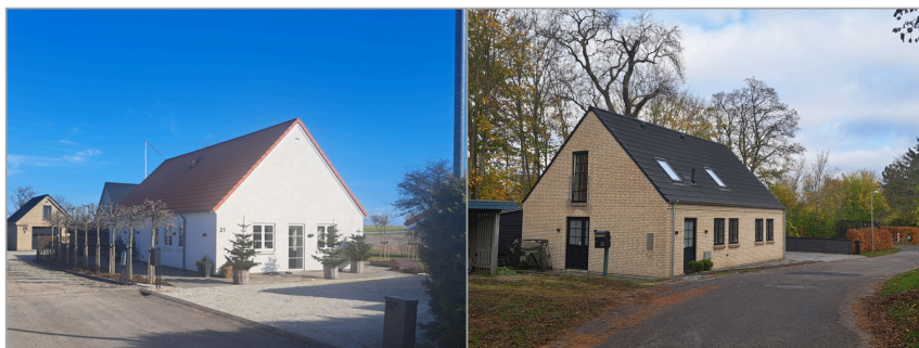
Billederne viser eksempler på nybyggeri, der følger princippet om det fagedelte længehus med saddeltag.
