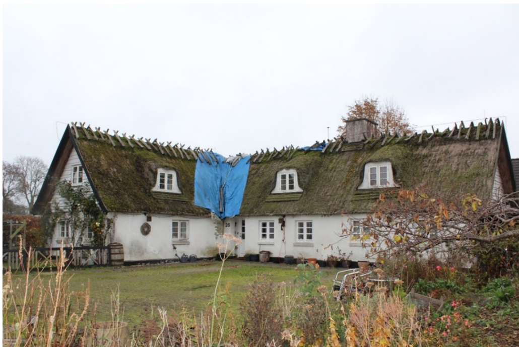
Foto: Kig til ejendommen fra Søndre Byvej
